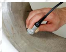
Messung der Stahldicke an Rohrwänden
