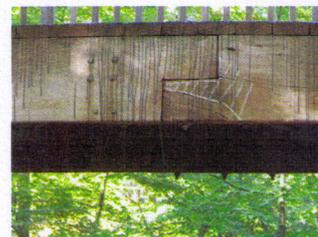
Abb.9 Tragfähiger Restquerschnitt im Bereich eines Gerbergelenks (schraffierter Bereich)
