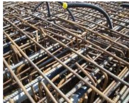
Abbildung 1 Bewehrungselemente in einem Brückenüberbau
